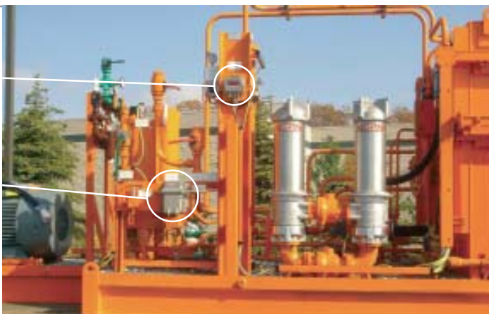
9: Öljyn kunnonvalvonta puristinhydrauliikassa.
